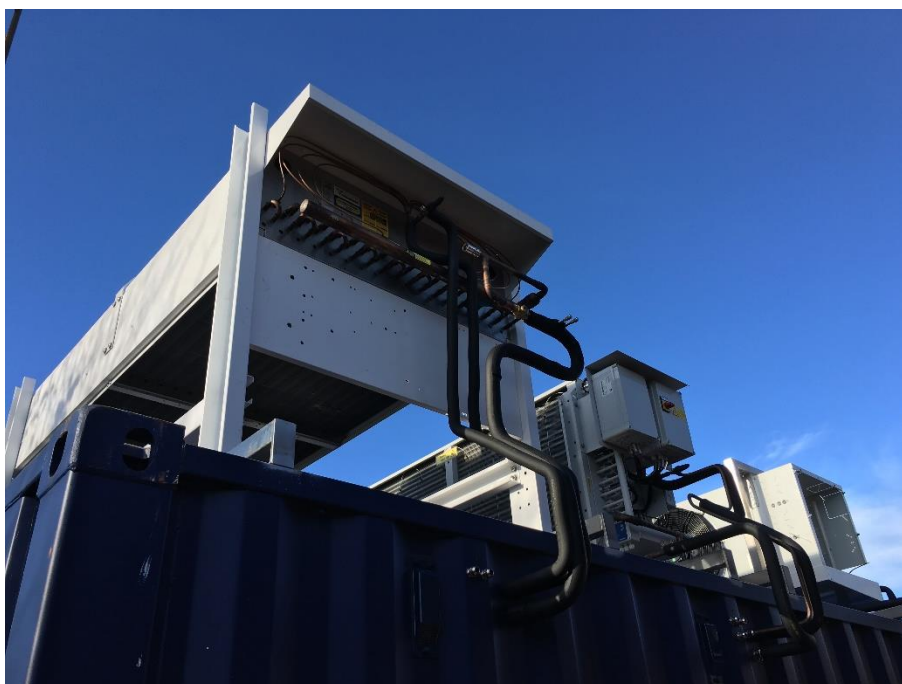
Figur 5-17: Fordamperne på toppen af containeren
