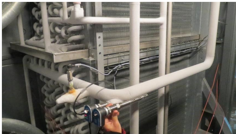
Figur 5-11: Foto af sensorens placering på nederste fordampere ved tunnel 9
