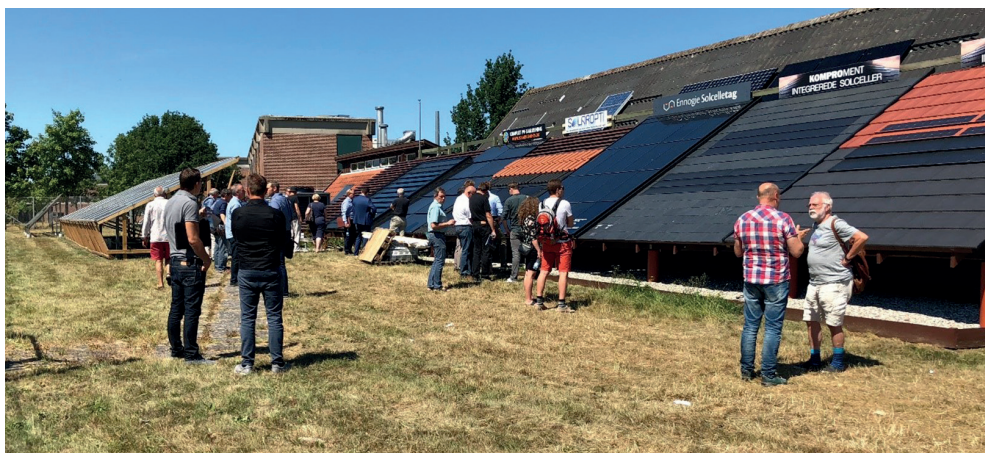
BIPV Demosite på Teknologisk Institut i Tåstrup. Her tagsystemer med bygnings indpassede solceller.
