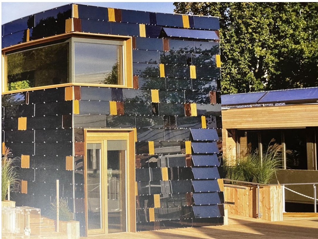
surPLUShome Germany Decathlon internationale vinder fra 2009 er et godt eksempel på helhedsløsning med bygningsindpassede solceller, som 0-energi byggeri (Sunpower solceller og Nilan varmepumpe)
