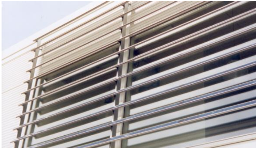
Eksempel på solafskærmningsløsning med solceller fra firmaet Alu-PV. Her anvendt til Studenterhus i Herning på en flot måde.
