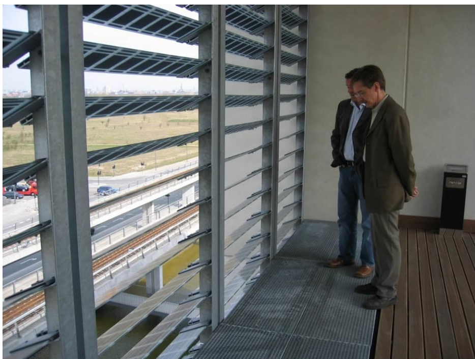
Københavns Energis hovedsæde med vinklede solceller fra Gaia Solar
