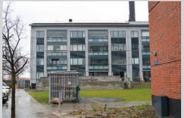
Hornemannsvænge housing retrofit in Valby
