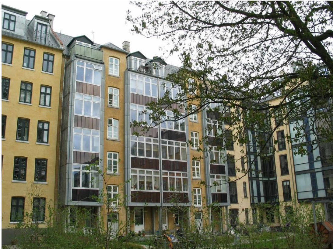
Eksempel på solceller i byfornyelsen til brystninger i Hedebygadekarreen
