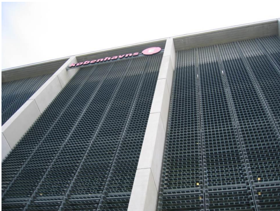
København Energi's hovedsæde med solceller til solafskærmning, dog med ret stor skyggeeffekt fra betonsøjler da solceller blev besluttet sent. Arkitekt Smith, Hammer & Lassen
